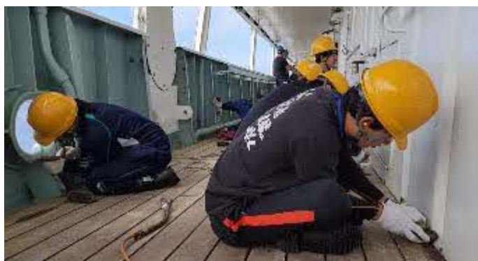
サビ打ち作業もしっかりと行っています。
