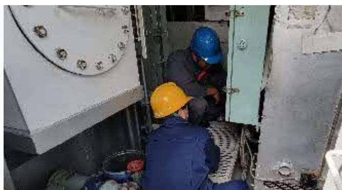
焼却炉現場にて作動手順の確認実習中
