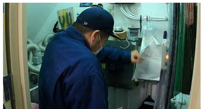
水密扉の締切作業実施中
