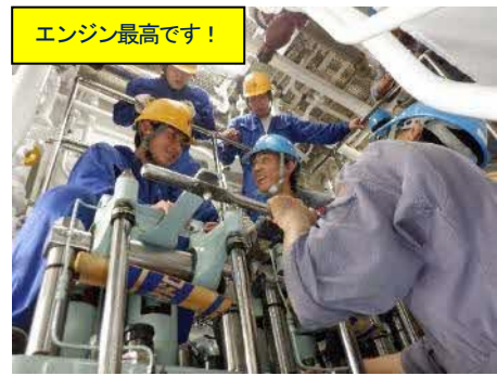
高圧管Oリング新替
