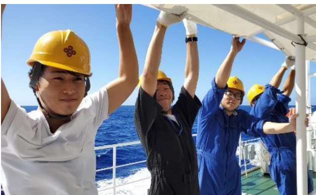
シート（雨除け）貼り作業
